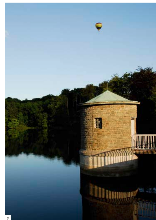
ABB.9 Einzige Trinkwassertalsperre im Quintett ist die Neyetalsperre in Wipperfürth. 6 Millionen m³ Wasser stauen sich hinter der rund 25 Meter hohen Staumauer.
