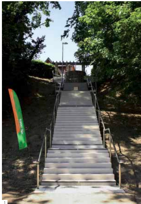
ABB.1 Die erneuerte, so genannte „Himmelsleiter“ in der Rehbockanlage in Leverkusen. Sie verbindet den Stadtteil Opladen mit der Siedlung Frankenberg.
